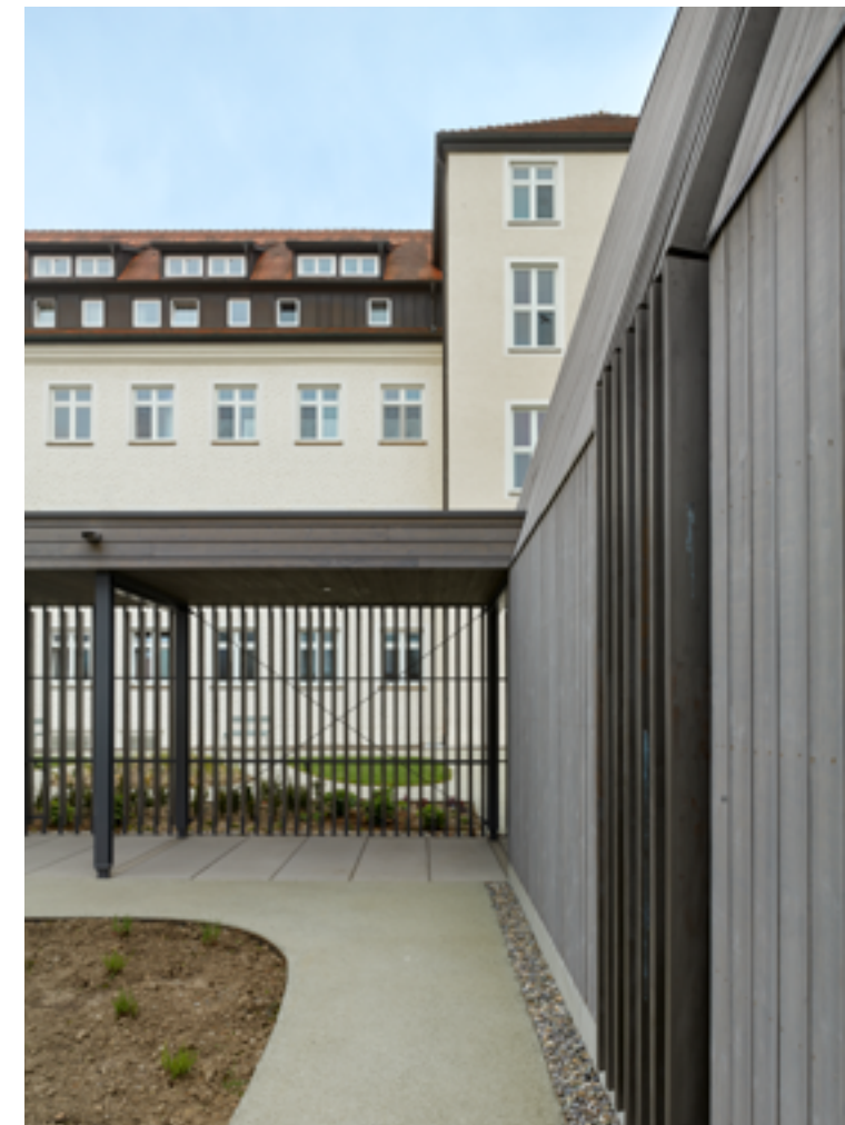
Die Umzäunung greift die Holzbauweise der Kapelle elegant auf
