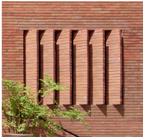
Münchner Volkstheater, Ziegellamellen/ Munich Volkstheater, brick slats
